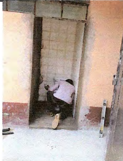
Instalación de baño
