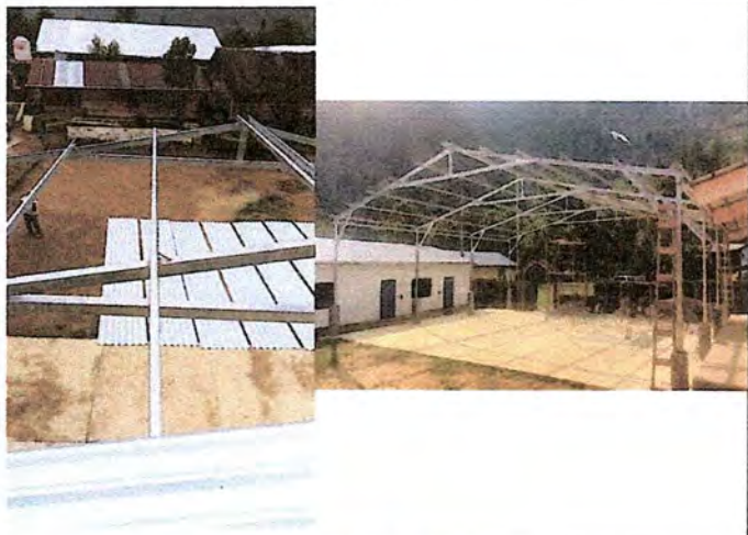
Instalación de lámina
