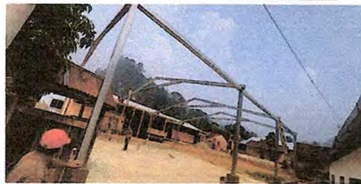
Soldadura e instalación de estructura metálica
