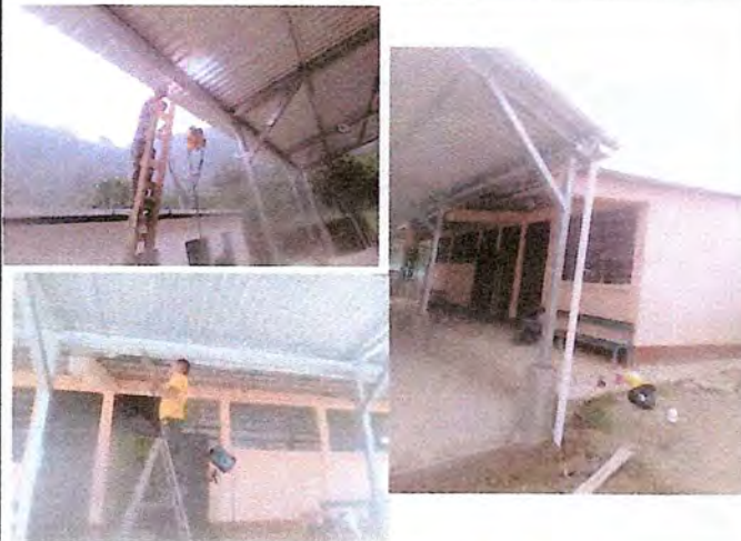
Instalación de canales y bajadas de agua
